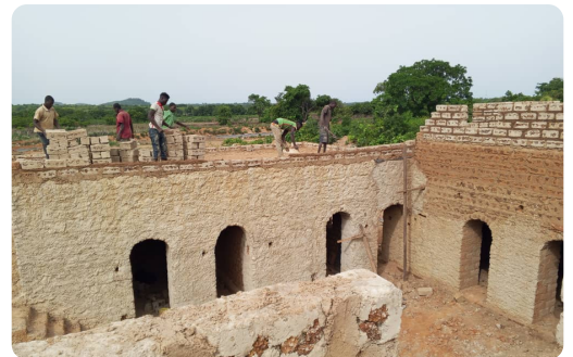
Chantier-école de construction du Palais du Balafon à Kouto
